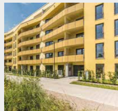
Baugebiet Schildacker, fertiggestellte Wohnungen im 1. Bauabschnitt
