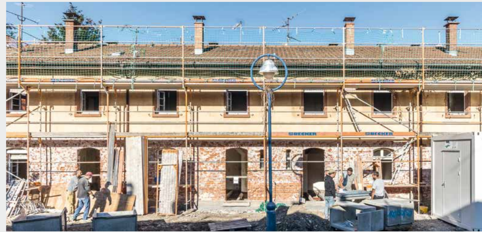
Außensanierung an den Knopfhäusle
