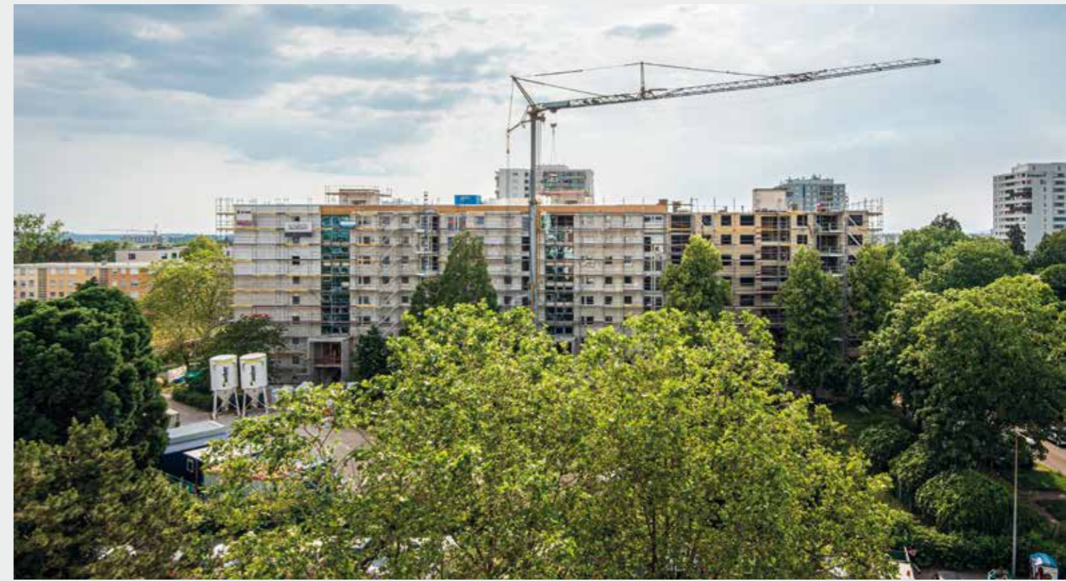
Sanierung der Wohngebäude im Hügelhoimer Weg
