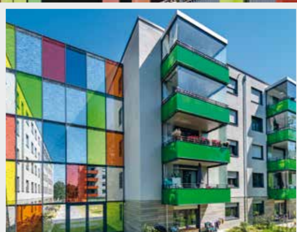
Blick auf die gläserne Schallschutzwand
