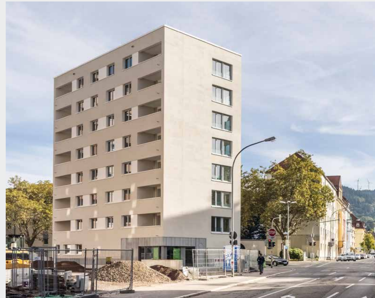
Das Gebäude in der Stefan-Meier-Straße 167a kurz vor der Fertigstellung
