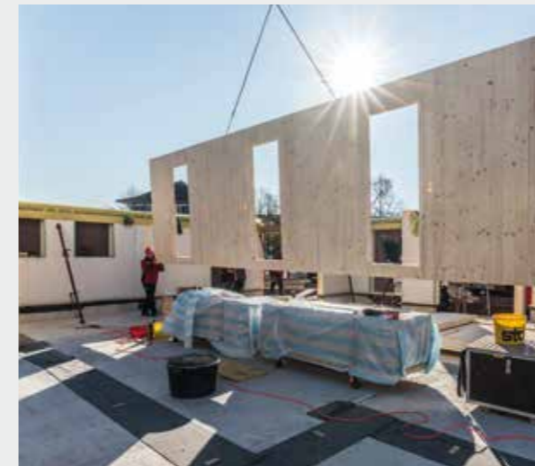
Aufrichten einer Wand in Holzbauweise
