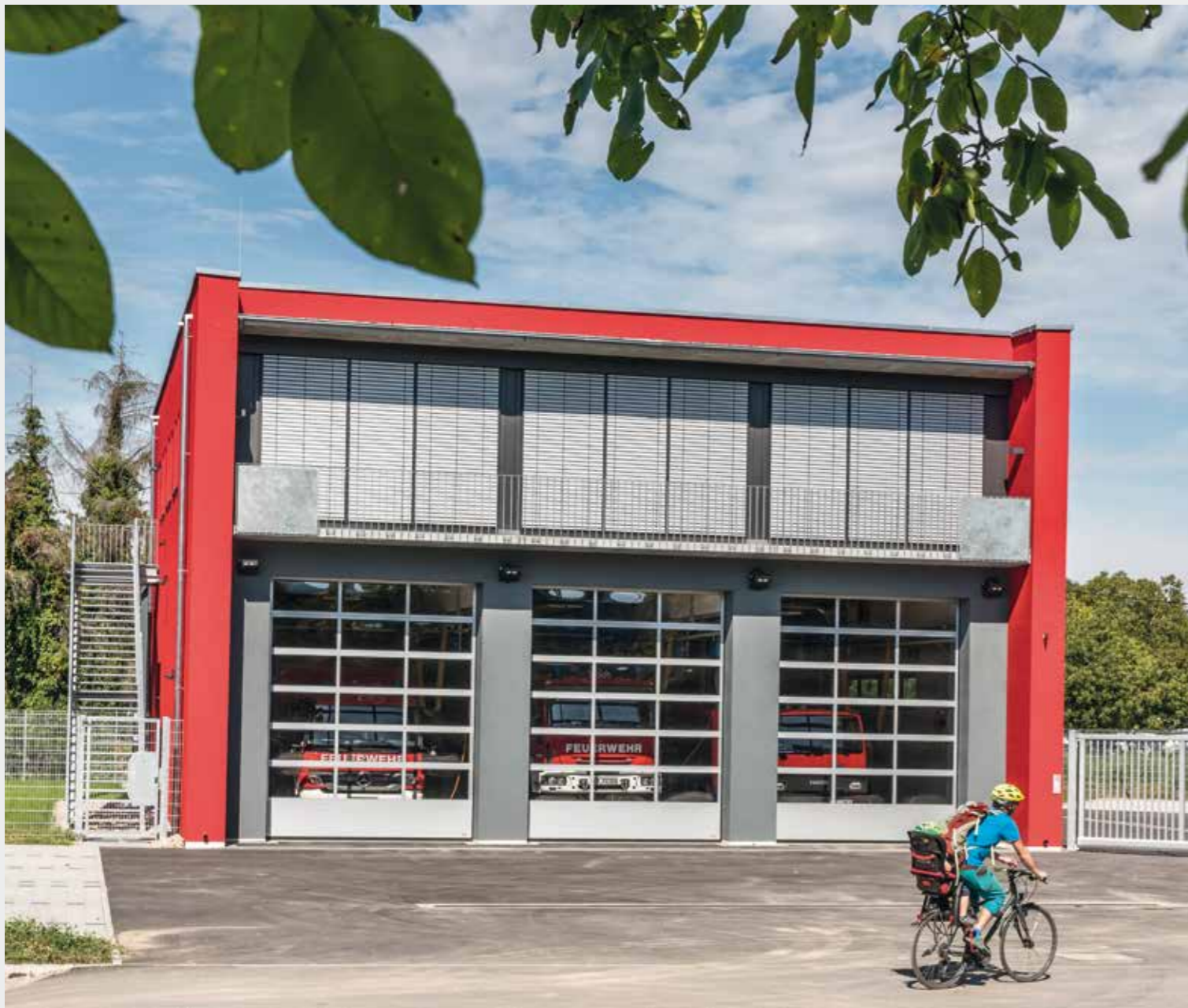
Feuerwehrhaus St. Georgen
