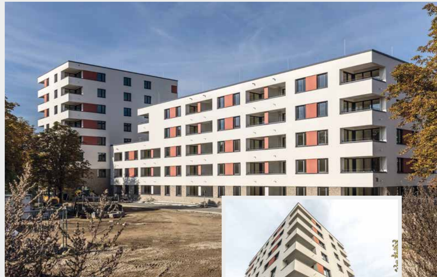
Der Breisacher Hof kurz vor der Fertigstellung.
