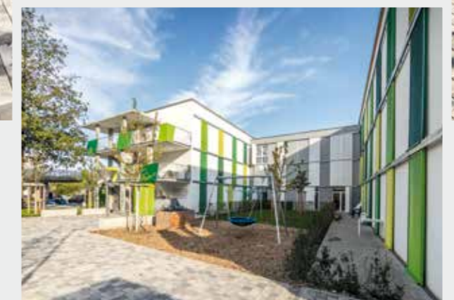
Wohnungen für Geflüchtete in der Bergäckerstraße, 2. Bauabschnitt
