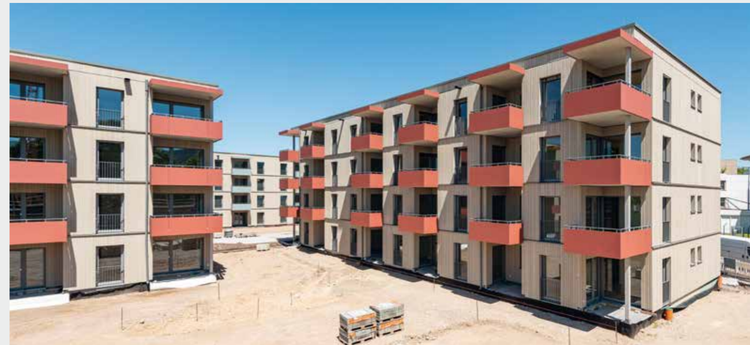
Die ersten Holzbauten kurz vor der Fertigstellung
