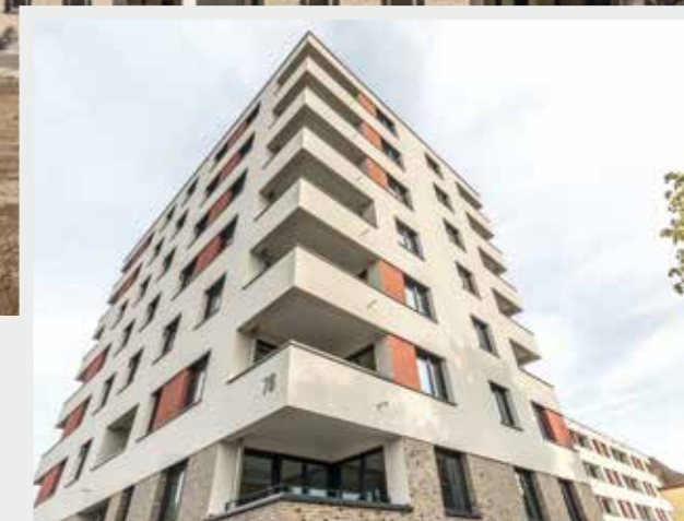
Der Kopfbau des Breisacher Hofes.
