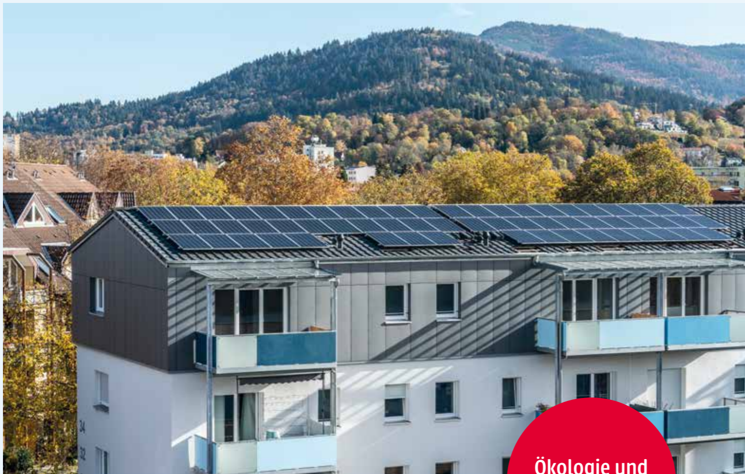
Die Photovoltaikanlage für das Mieterstrommodell in der Belchenstraße
