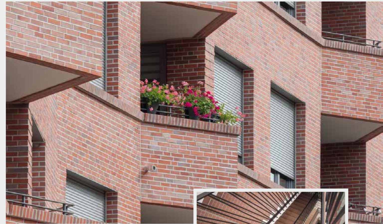
Die Balkone mit ihrer Spitze nach vorne sind luftig und hell. Ihr Auf- und Ab strukturiert die geklinkerte Fassade zusätzlich.
